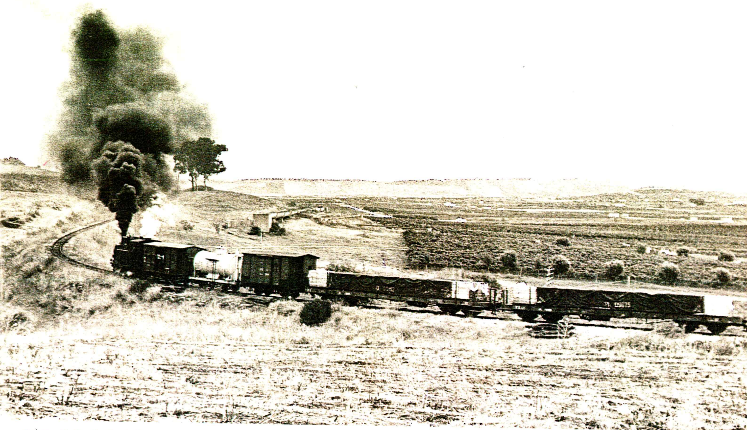
Rampe di Menfi. Rotaie bagnate, la R.302.019 sotto sforzo, slitta, si ferma, riparte piano piano. Era il 17 agosto 1977.
